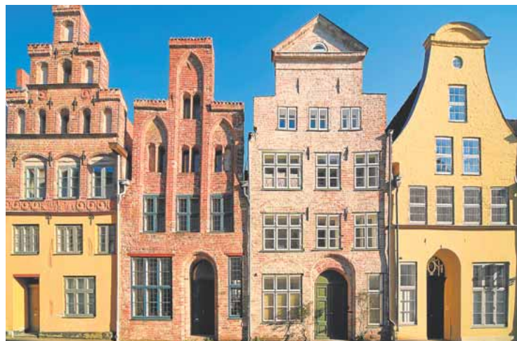
Fachadas de las viviendas de comerciantes burgueses en Lübeck
