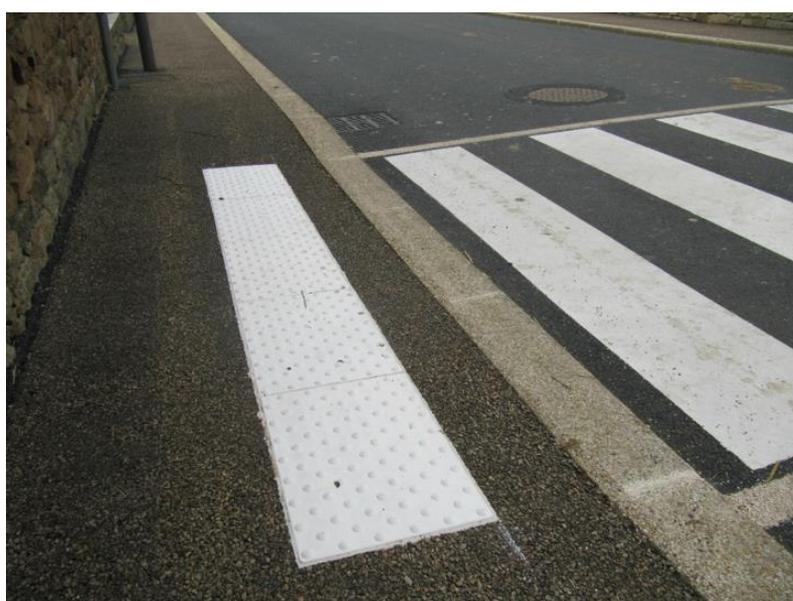
Figure 43 - Bande de détection podotactile pour personnes malvoyantes
