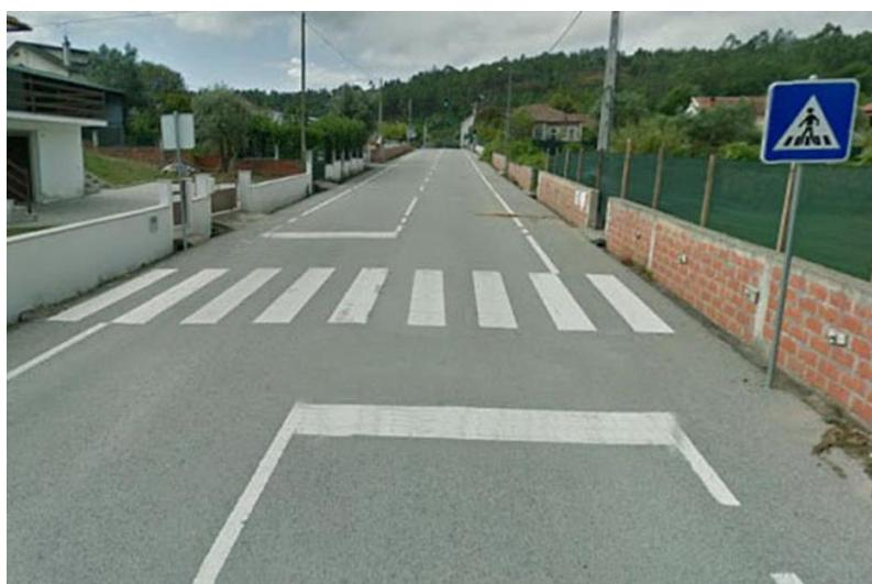
Figure 42 - Exemple de ligne d'effet d'un passage piéton et ligne continue dissuadant le dépassement
