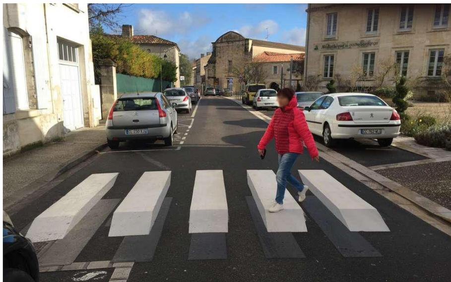
Figure 47 - Exemple de marquage d'une traversée piétonne avec un effet 3D.
