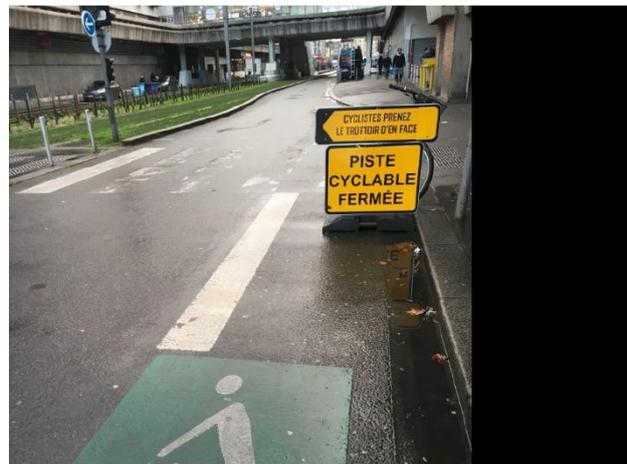
Figure 21 - Traitement d'une continuité cyclable en situation de travaux
