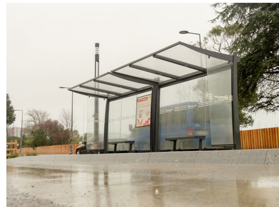
Insertion centrale des voies du Bus Nouvelle Génération.
