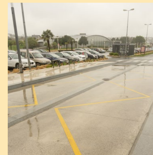
Plateforme en béton.
