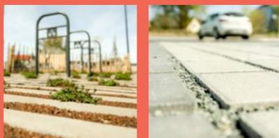
Joint plantés et joints gravillonnés pour la désimperméabilisation des parkings.
