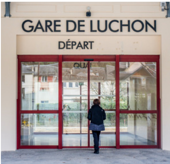
Le nouveau bâtiment voyageur a été livré en février dernier. ©Léo Arcangeli – Région Occitanie.
