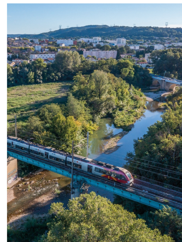
La circulation des trains est interrompue en semaine sur la Rive Droite du Rhône depuis le 16 mars. ©Lydie Lecarpentier - Région Occitanie.
