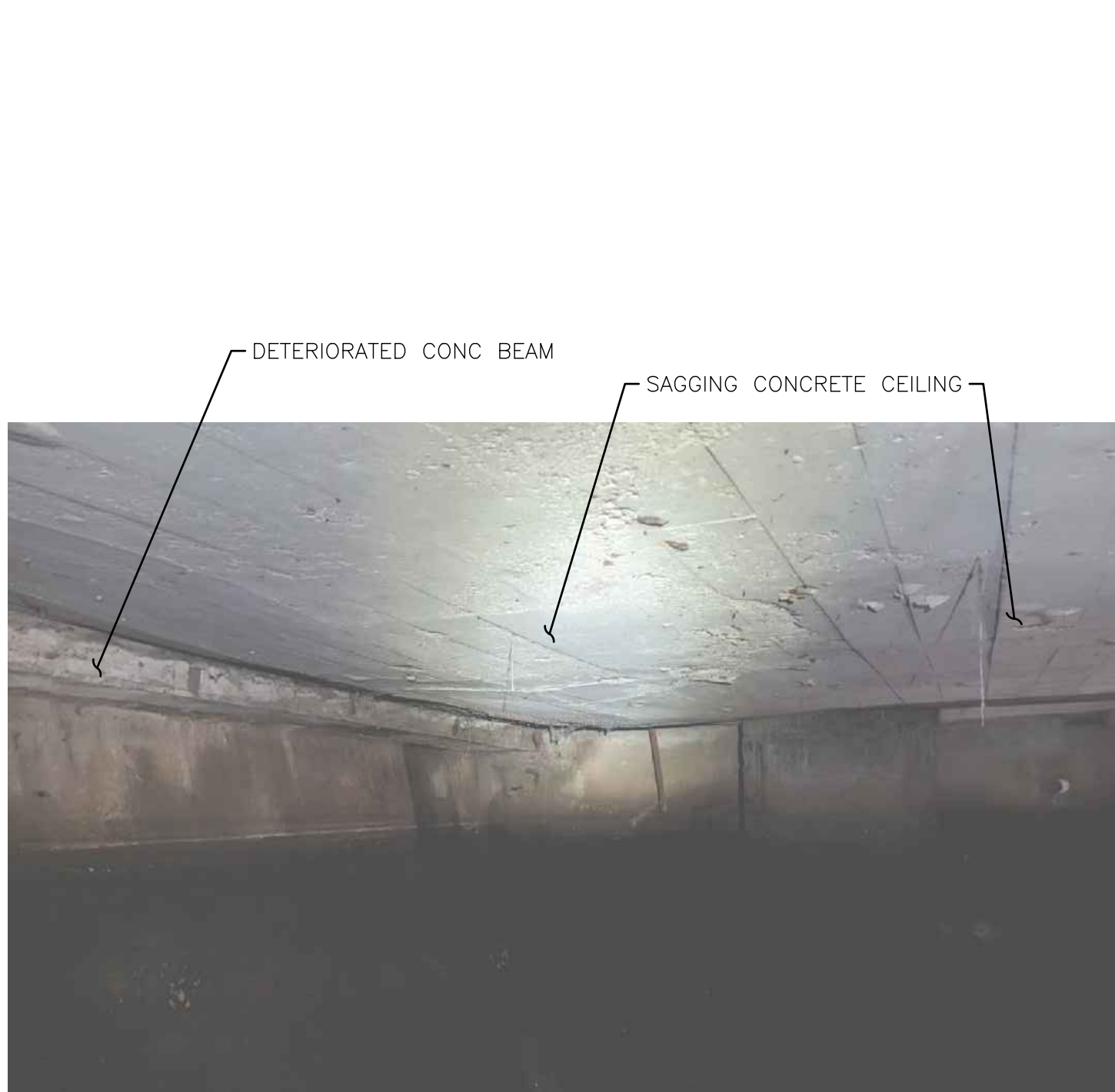
PH5 SAGGING CEILING CONCRETE C-4 SCALE: NONE
