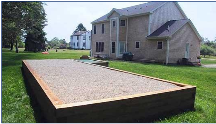
Recirculating sand filter, courtesy: AJFoss.com
