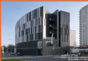
Locaux d'UPKAZE à Reims
