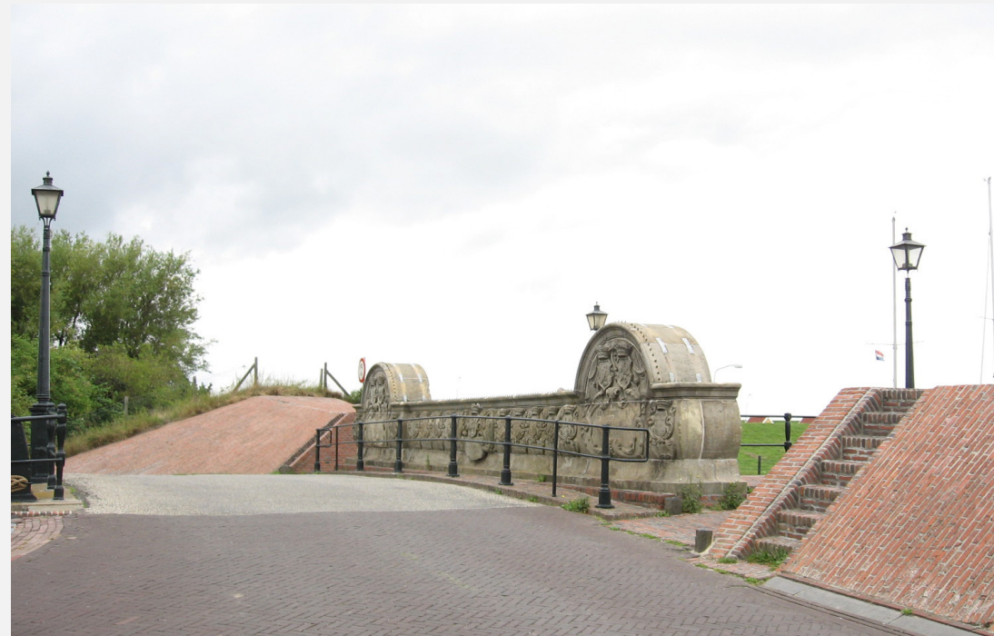
Oude sluis Termunterzijl
