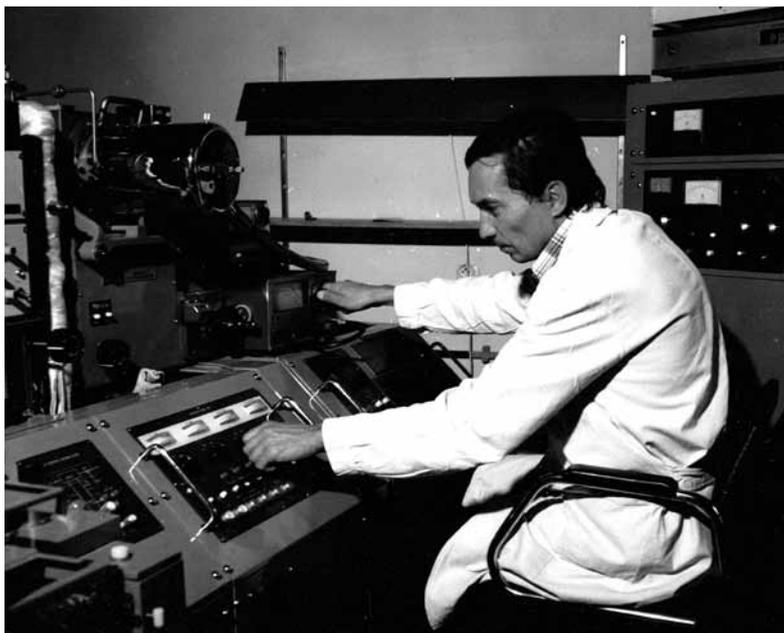
Obrázek 4: Přední ovládací část a vpravo vzadu zdroje hmot. spektrometru Jeol JMS-01-SG2
