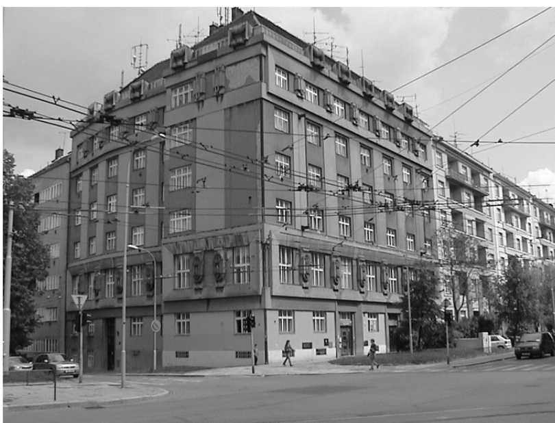
Obr. 1: Budova, ve které sídlil starý ústav UIACh v přízemí a 1. patře rohu dnešních ulic Kounicova a Nerudova.
