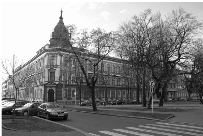
Obr. 1: Dnes zrenovovaná budova bývalé strojnické průmyslovky na Náměstí Legii (dříve Leninovo nám.), sídlo VŠCHT v Pardubicích.
