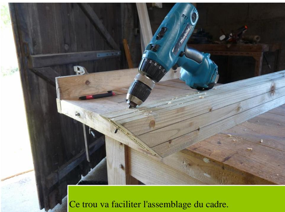
Ce trou va faciliter l'assemblage du cadre.
