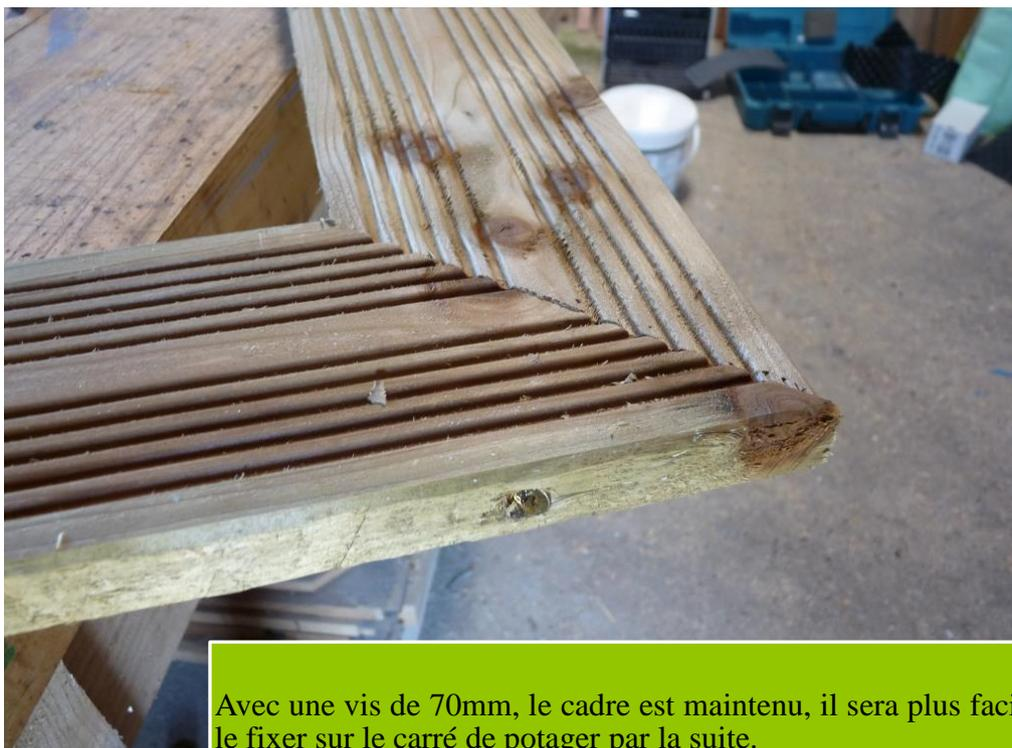
Avec une vis de 70mm, le cadre est maintenu, il sera plus facile de le fixer sur le carré de potager par la suite.
