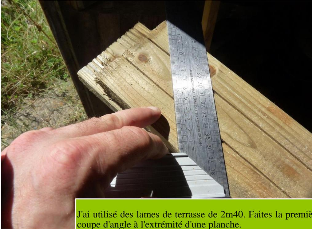
J'ai utilisé des lames de terrasse de 2m40. Faites la première coupe d'angle à l'extrémité d'une planche.
