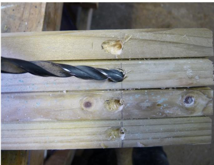
**Orientez vos lames de terrasses et percez à 4mm une des 2 pointes. Pour faciliter le passage de la tête de vis et éviter l'éclatement, élargissez le trou avec une mèche à métaux de 10mm.**
