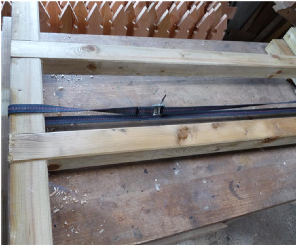
Assemblez le premier coté. Utilisez des sangles ou des serres joints pour serrer l'ensemble et vissez la traverses basse avec les tirefonds de 140 mm. Attention à l'equerrage
