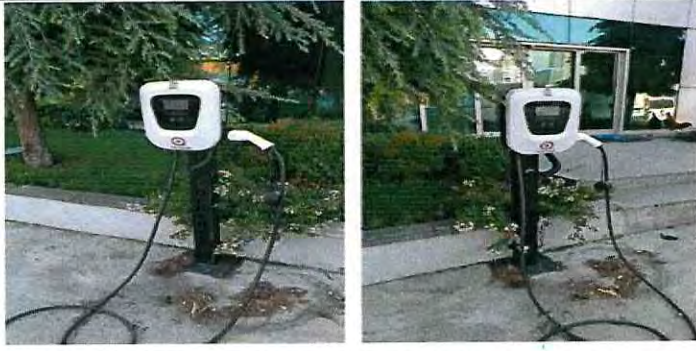
AC22, 22kW gücünde EVSE Level 2 şarj istasyonu modelidir. AC şarj kabiliyetine sahip araçlar tarafından kullanılabilir.
