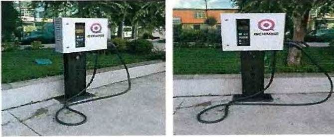
DC 30; 30kW gücünde EVSE Level 3 şarj istasyonu modelidir. AC ve DC şarj kabiliyetine sahip elektrikli araçlar tarafından kullanılabilir.
