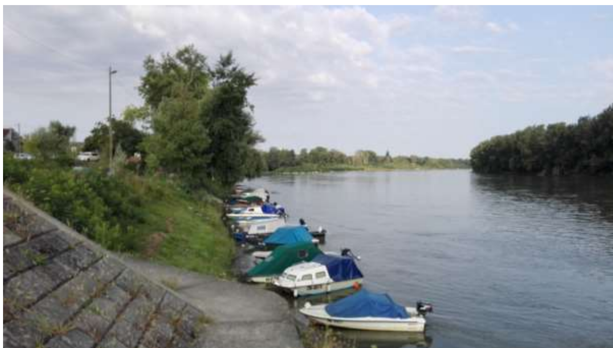
Slika 2-3: Postojeća obaloutvrda kanalizacijskog ispusta grada Osijeka
