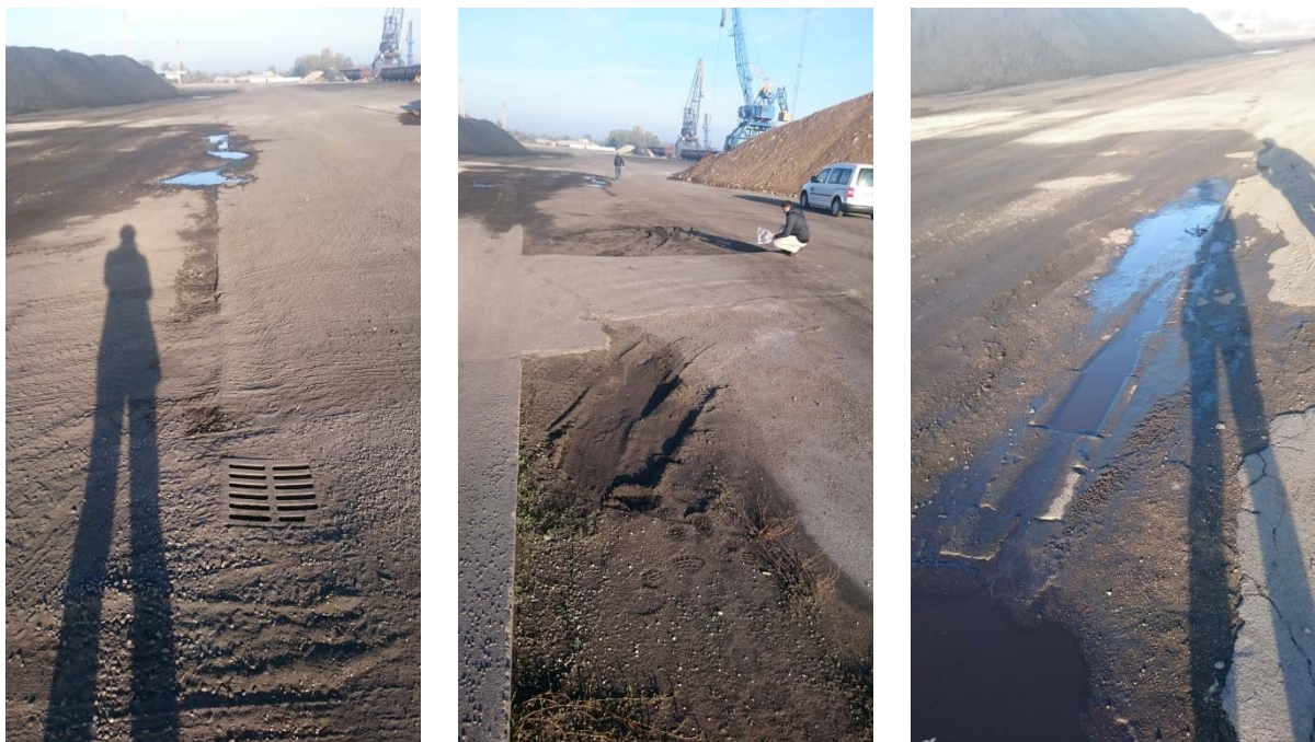
Slika 2.1: Postojeće stanje prometnice
