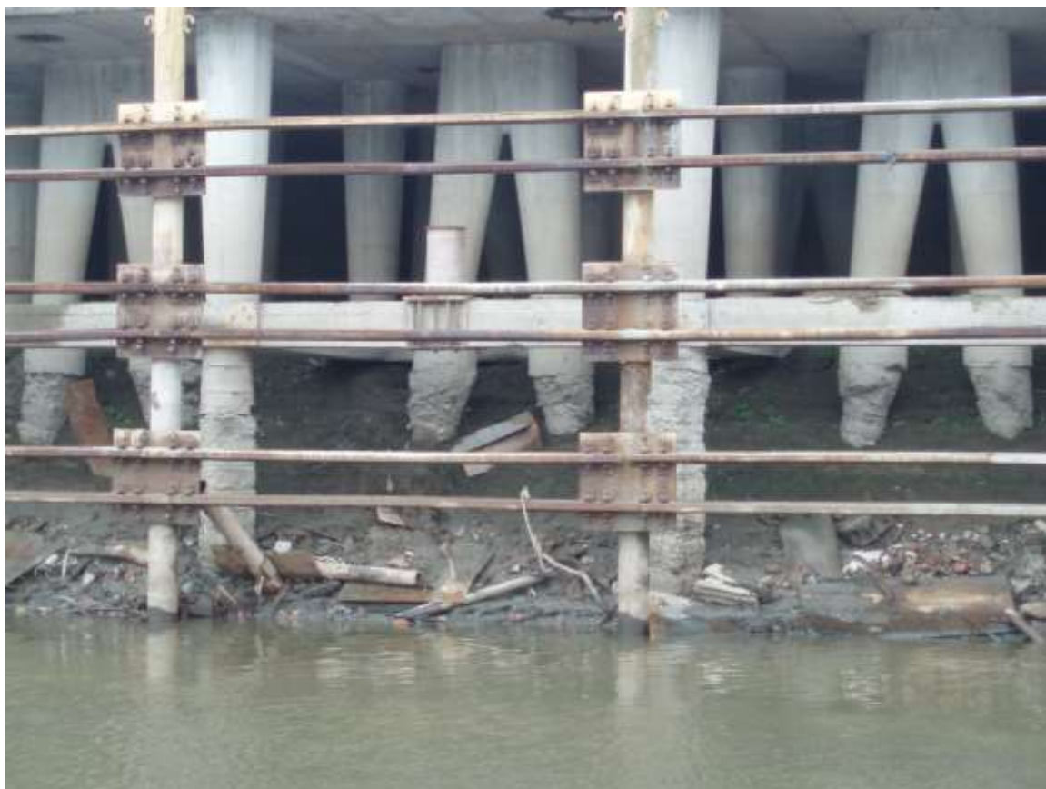
Slika 2.1: Konstrukcija vertikalne obale u Luci Osijek
