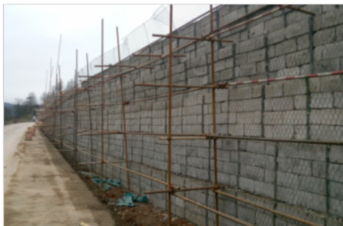
图一：项目施工中
