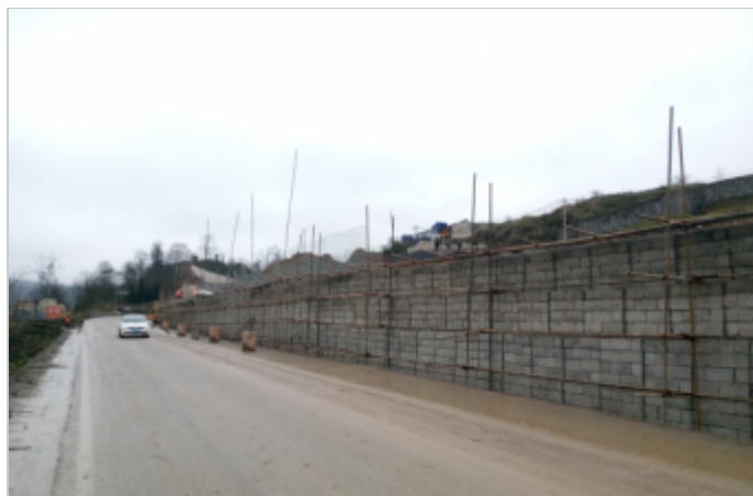
图二：项目施工中
