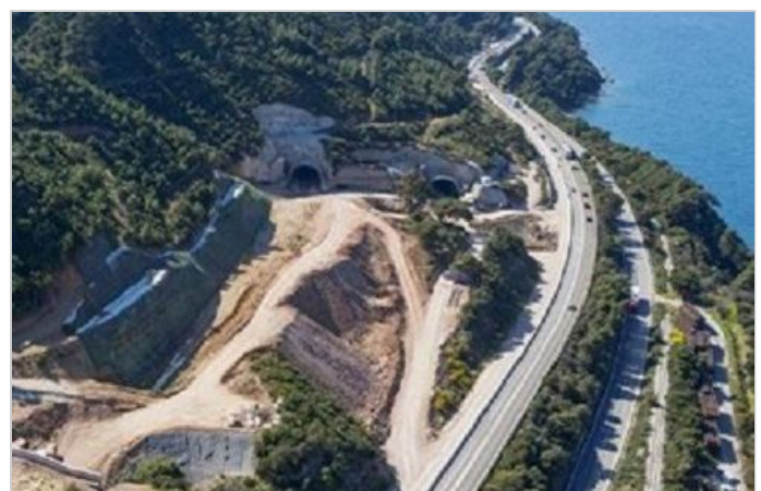
Αποψη του Α/Δ, κατά τη κατασκευή
