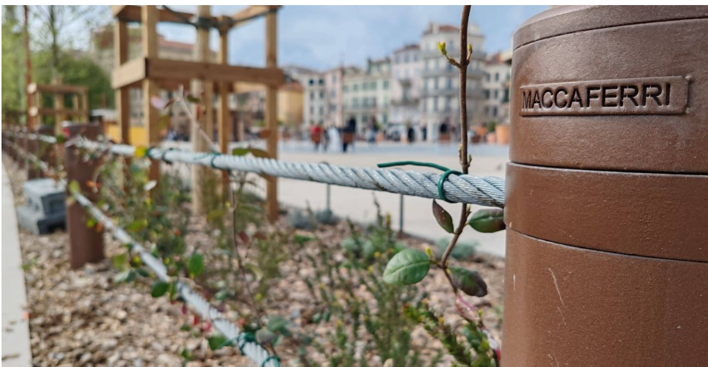
Ici : Poteaux Galvanisés à chaud et peinture RAL 2525
