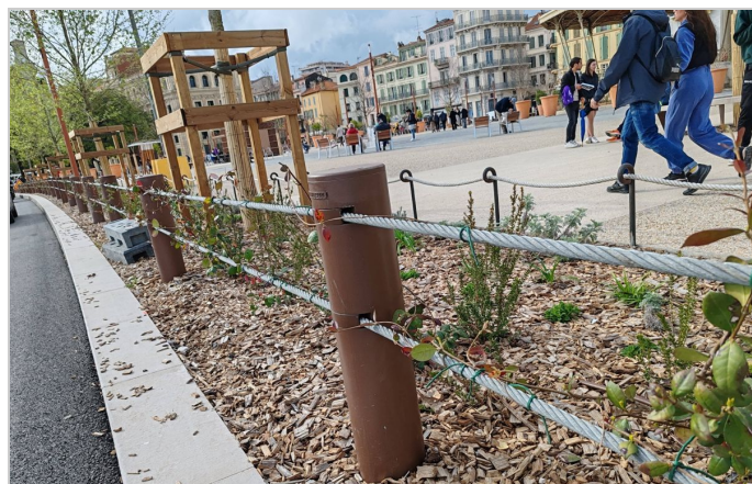
MacSafe™ 300 de hauteur 0,90m et 3 lignes de 36m ; 60m ; 60m
