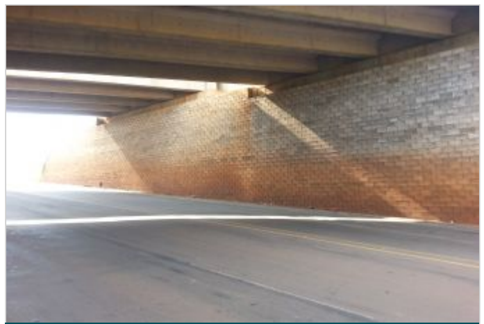
Durante la Obra
