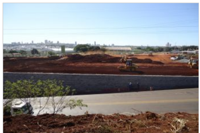
Durante la Obra
