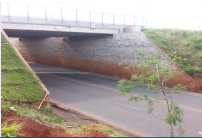
Durante la Obra
