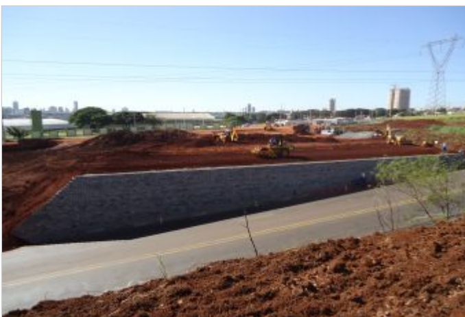
Durante la Obra
