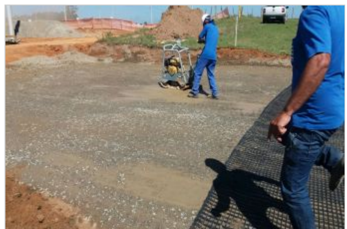
Durante a obra
