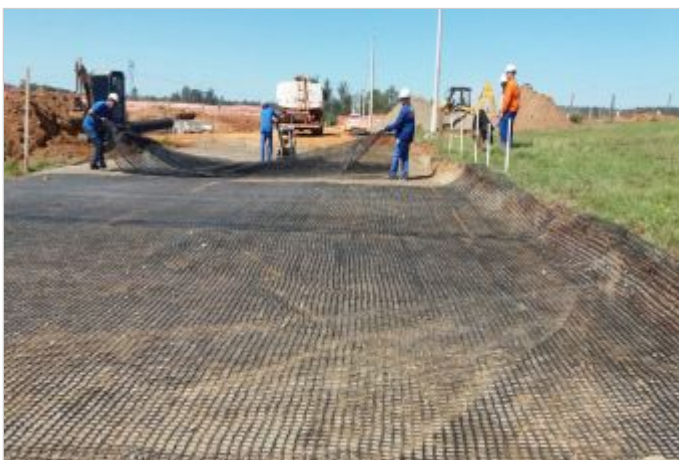
Durante a obra
