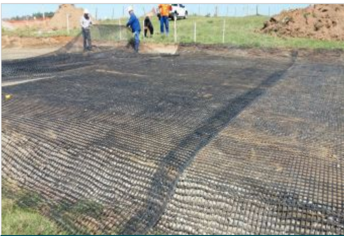
Durante a obra
