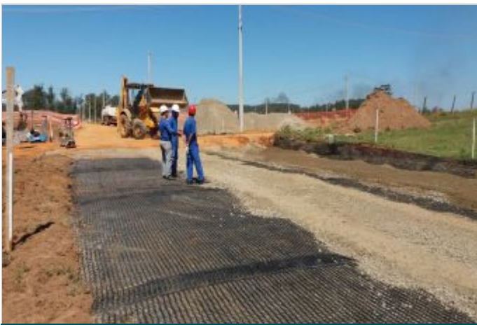
Durante a obra
