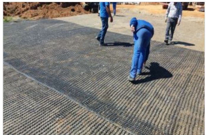
Durante a obra
