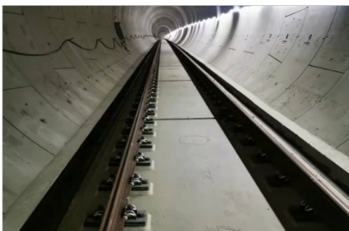
图5-铺轨施工完成
