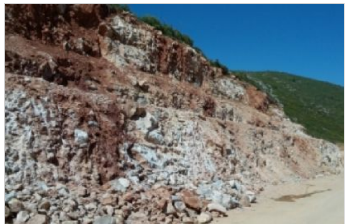
Μετά την εκσκαφή
