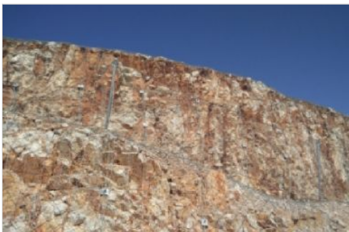
Ολοκλήρωση τοποθέτησης Φράκτη RB750 & HEA πάνελ
