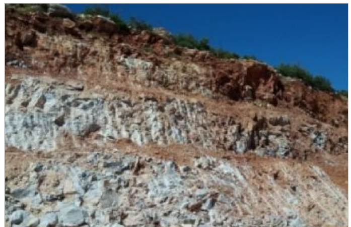
Μετά την εκσκαφή
