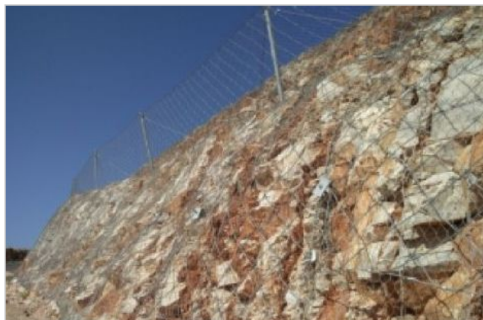
Ολοκλήρωση τοποθέτησης Φράκτη RB750 & HEA πάνελ
