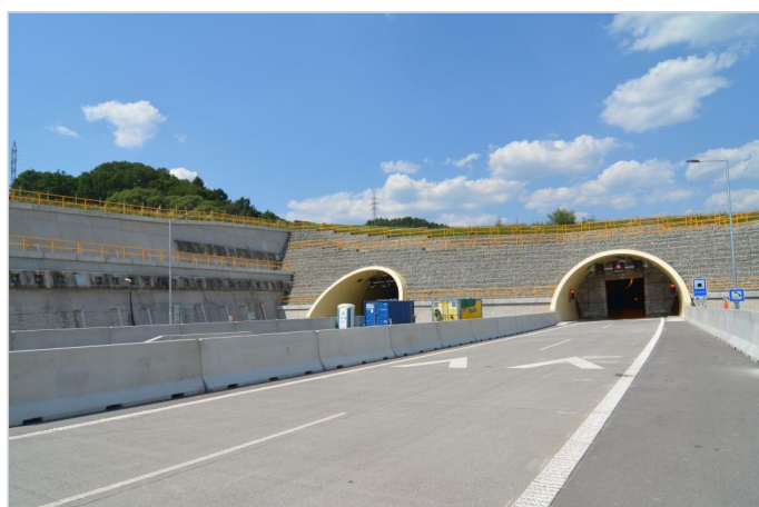
Východný portál tunela Ovčiarско
