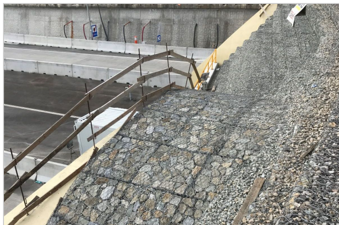
Pohľad na konštrukciu v realizácii
