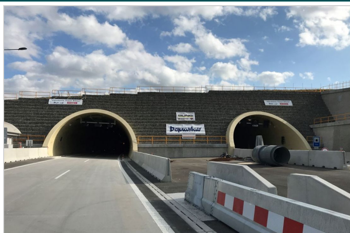
Západný portál tunela Žilina
