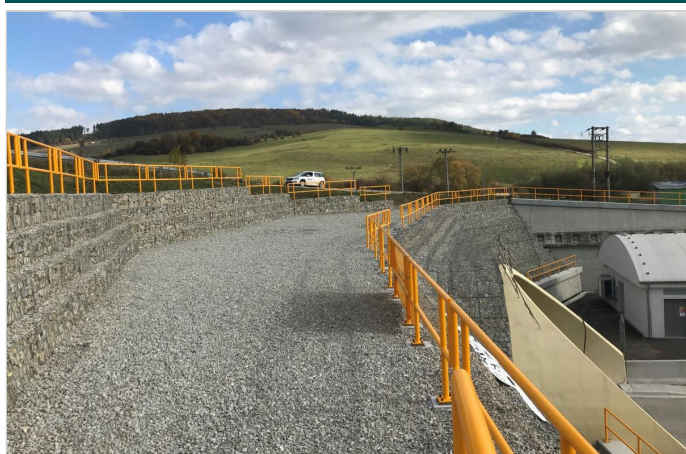
Pohľad na konštrukciu v realizácii
