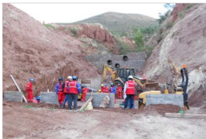
Durante la Obra
