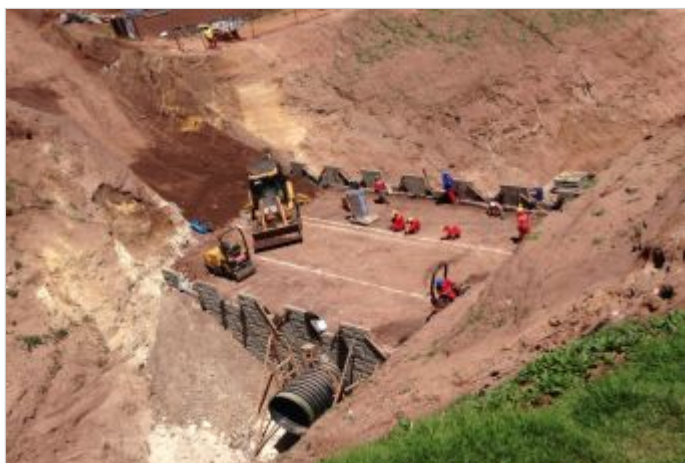
Durante la Obra
