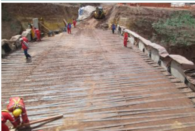
Durante la Obra
