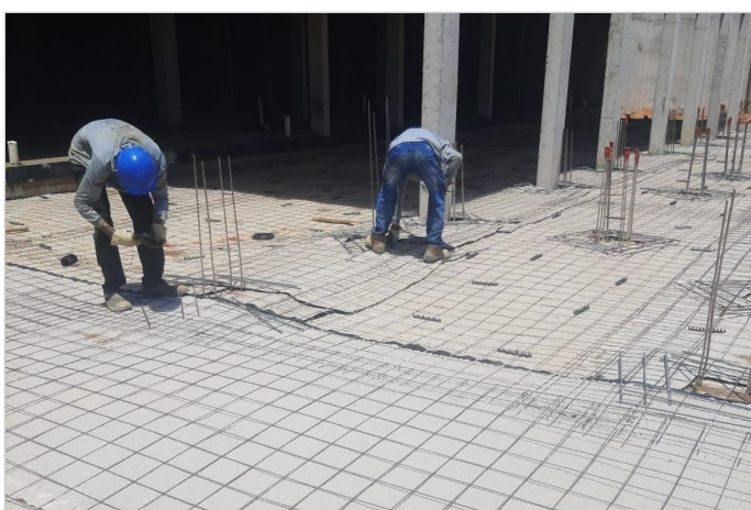
Durante a obra
