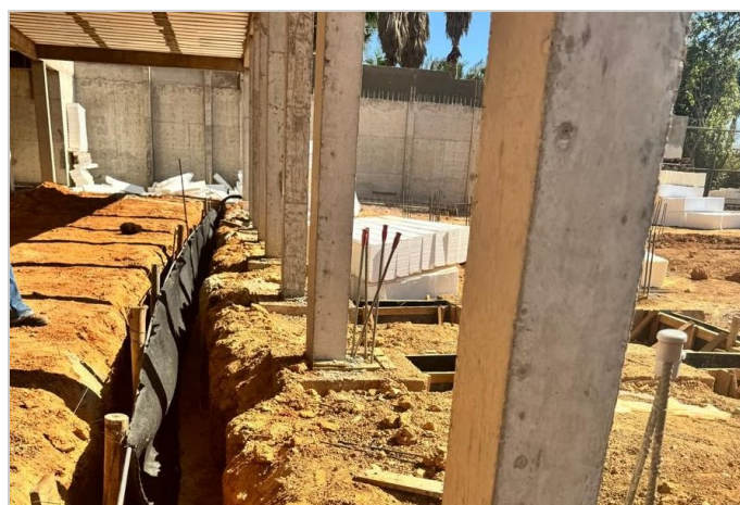
Durante a obra
