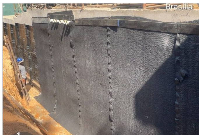
Durante a obra
