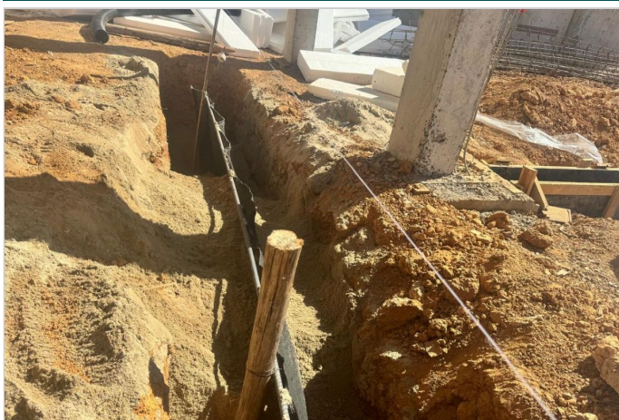
Durante a obra
