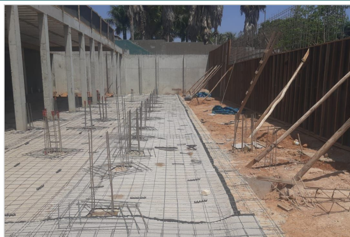
Durante a obra
