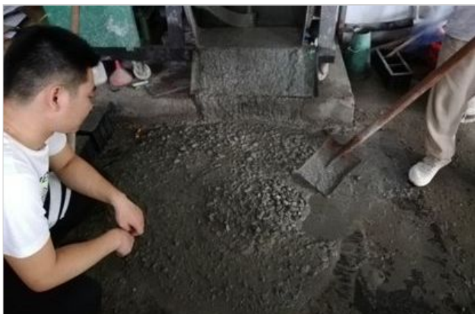
图3 钢纤维混凝土配合比室内调配
