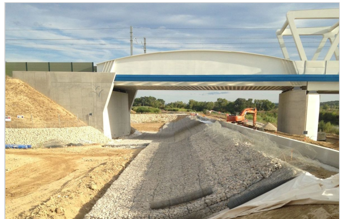
Rive droite pendant la mise en oeuvre
