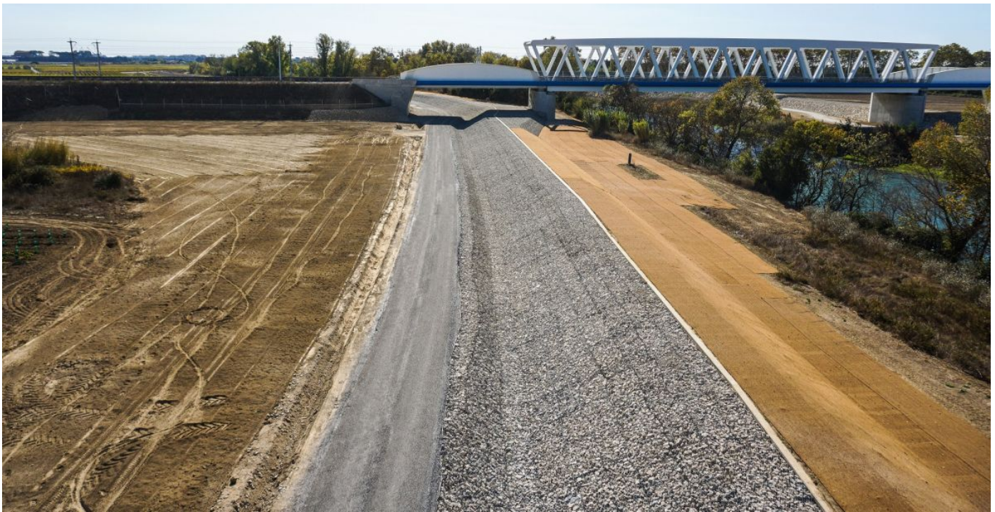
Après les travaux
