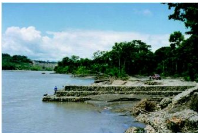
Durante a obra
