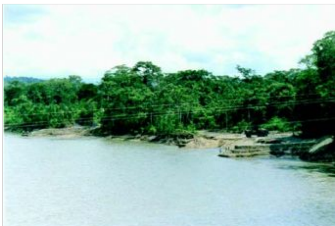
Durante a obra
