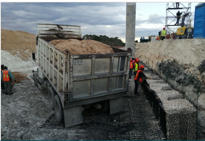
Durante la Obra
