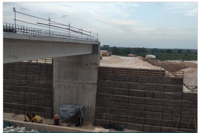
Durante la Obra
