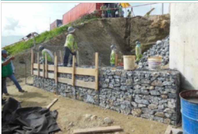
Durante la Obra
