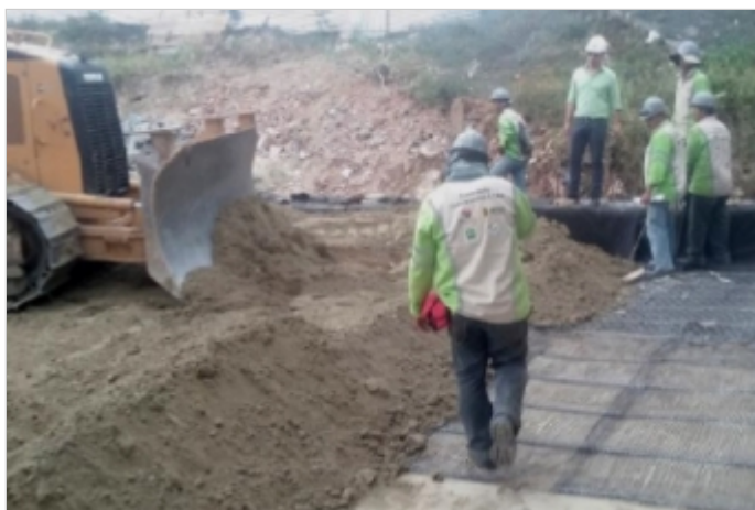
Durante la Obra
