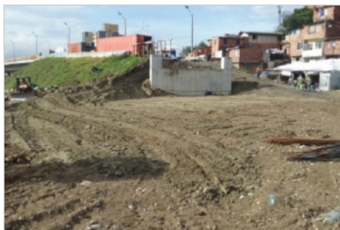
Durante la Obra
