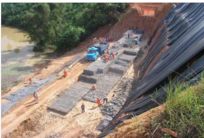
Durante la Obra
