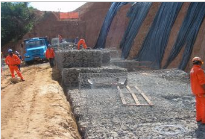
Durante la Obra
