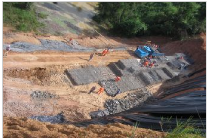
Durante la Obra
