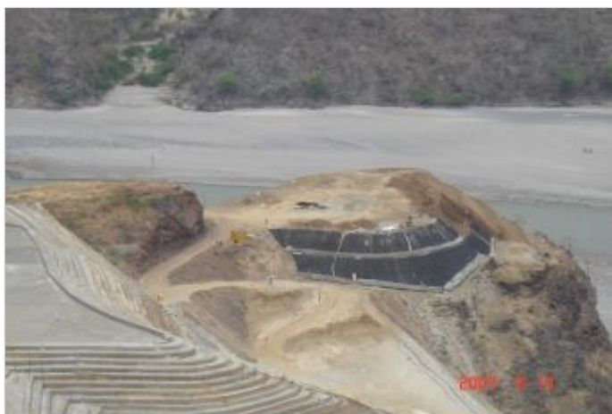
Durante a obra
