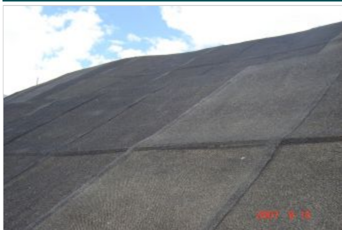
Durante a obra
