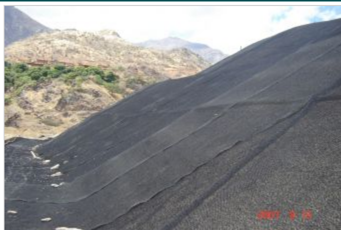
Durante a obra
