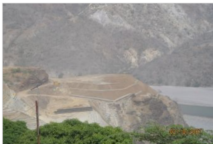
Durante a obra
