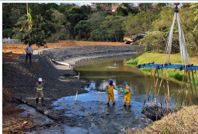
Durante a obra
