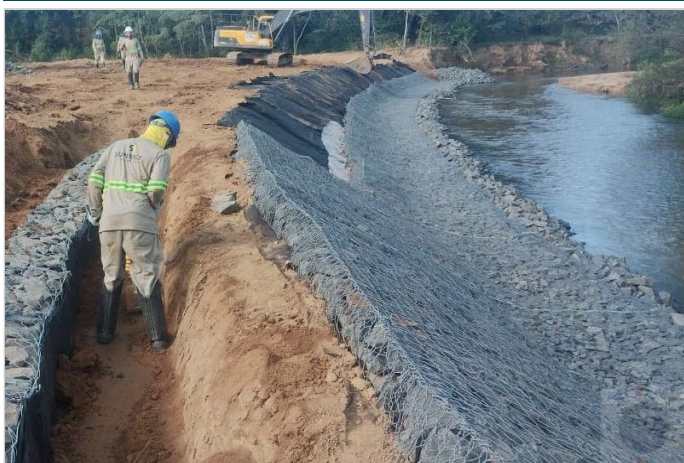
Durante a obra
