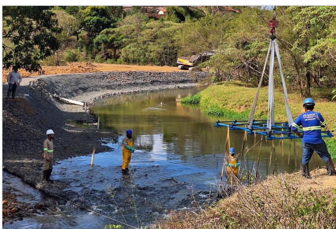
Durante a obra
