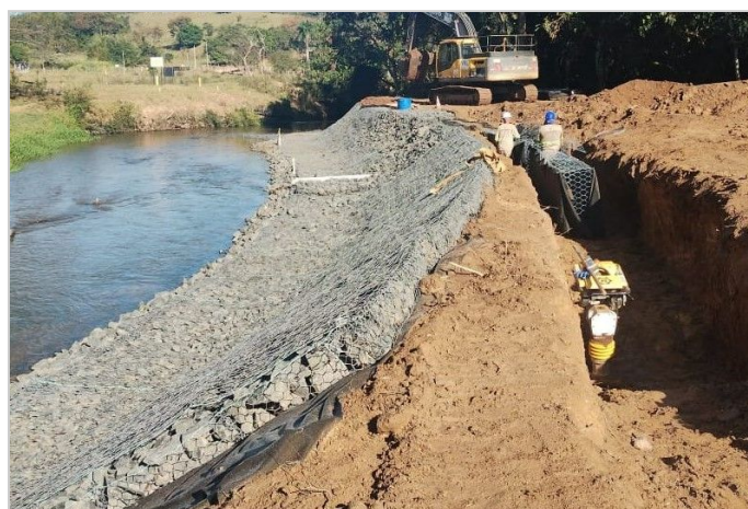
Durante a obra
