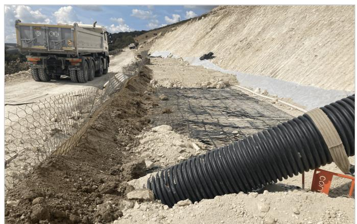
Grillage Double Torsion, géogrilles et géocomposite de drainage
