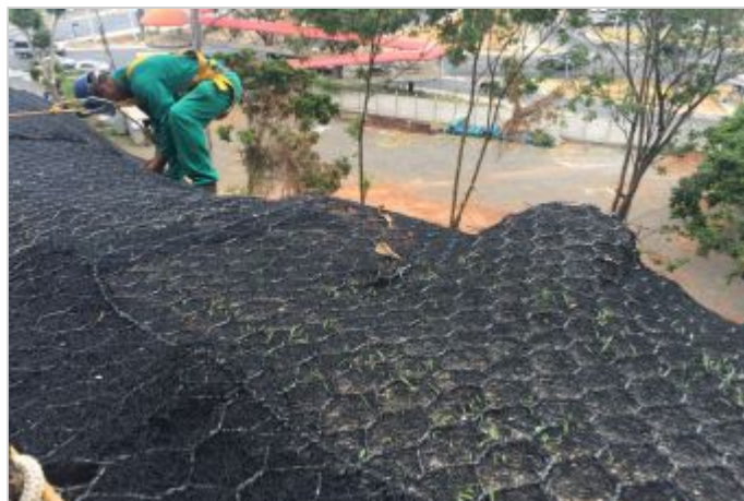
Durante la Obra
