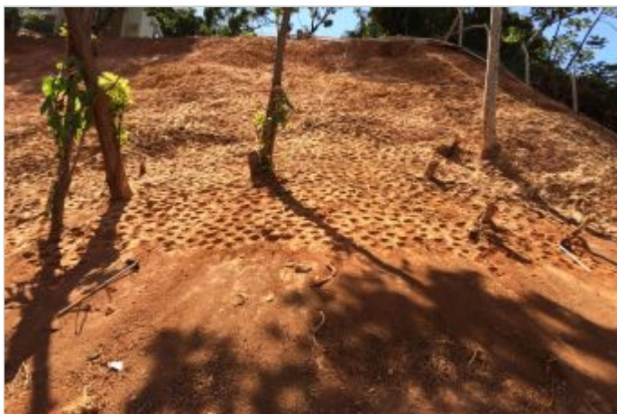
Durante la Obra
