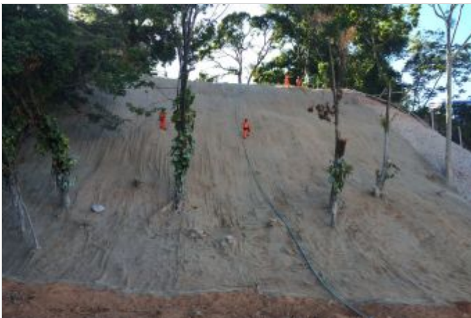
Durante la Obra
