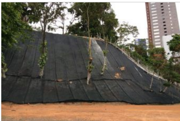
Durante la Obra
