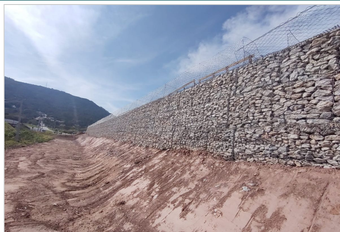
Durante a obra
