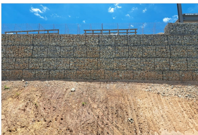
Durante a obra
