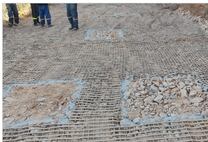
Antes da Obra
