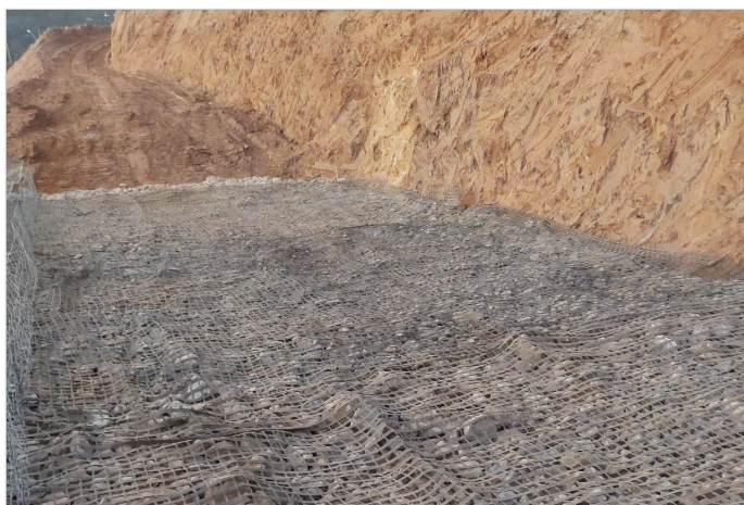
Durante a obra
