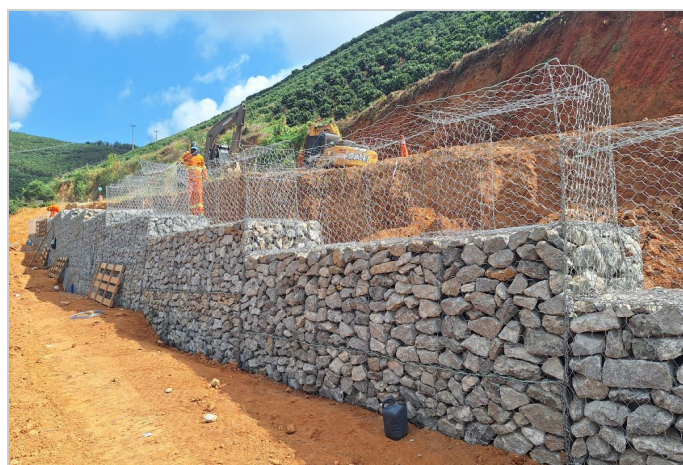
Durante a obra
