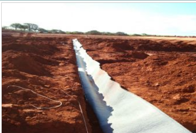
Durante a obra
