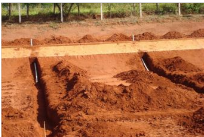
Durante a obra
