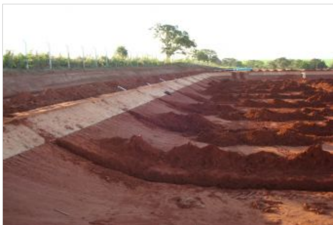
Durante a obra
