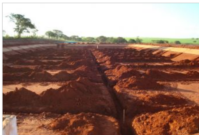
Durante a obra
