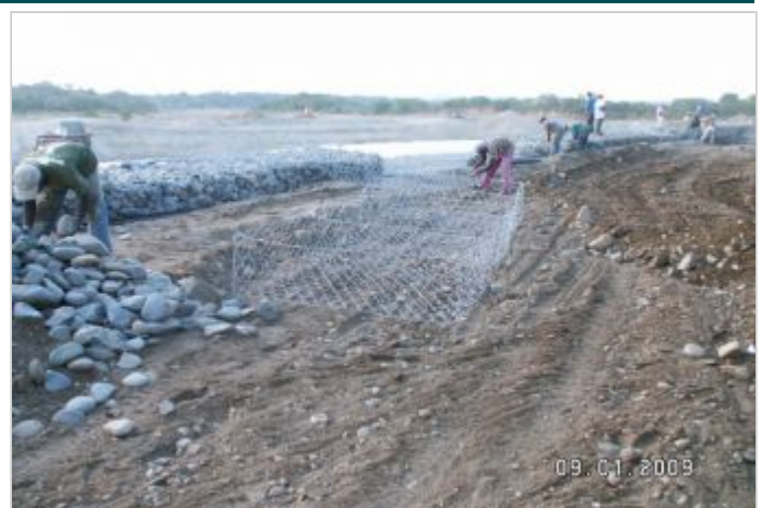
Durante a obra
