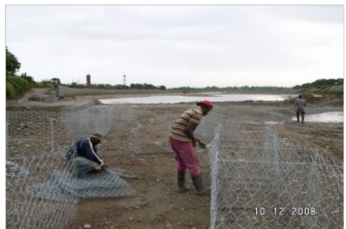
Durante a obra
