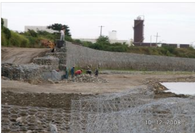
Durante a obra
