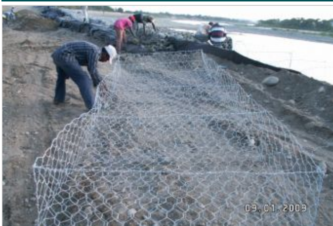
Durante a obra
