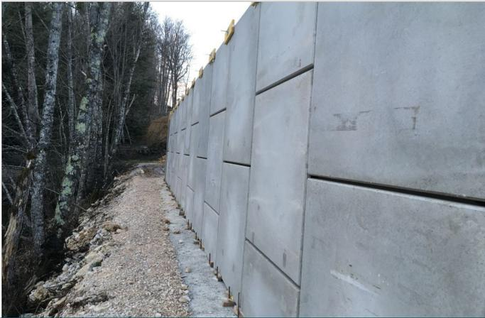
Parement écailles béton
