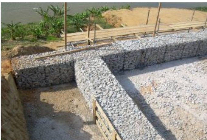
Durante a obra
