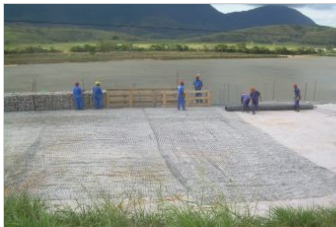
Durante a obra
