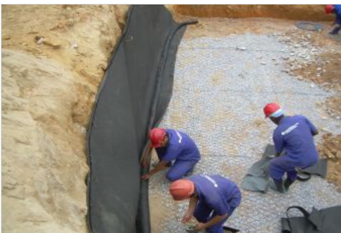
Durante a obra
