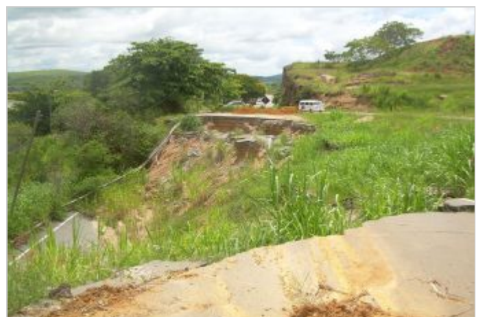
Durante a obra
