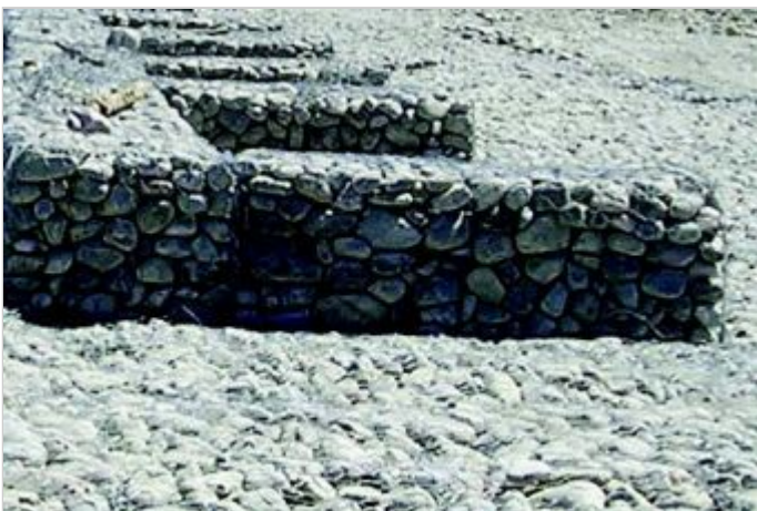
Durante a obra
