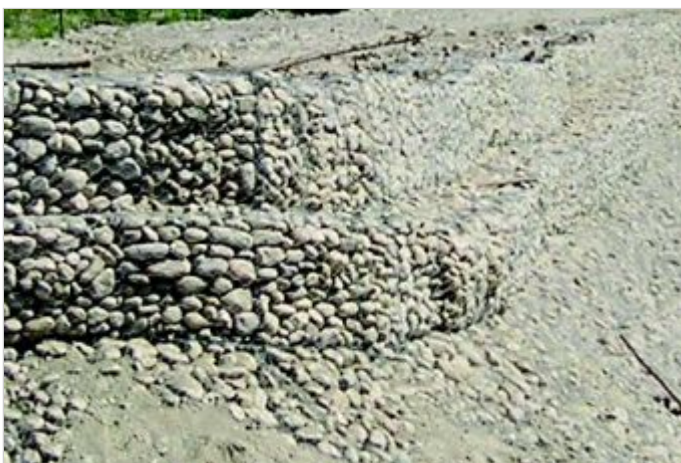
Durante a obra
