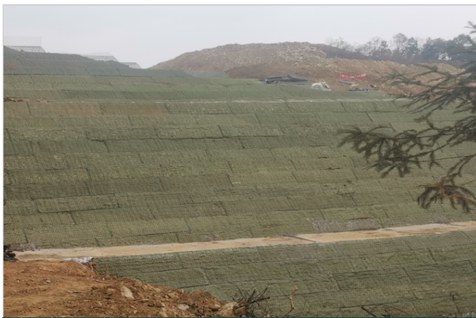
施工完成照片
