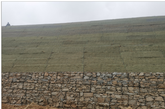
施工完成照片
