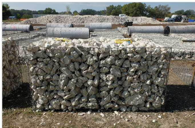
Préparation des structures
