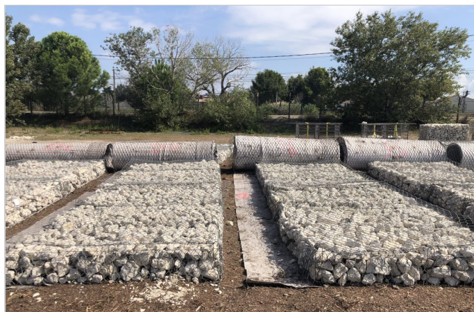
Préparation des structures
