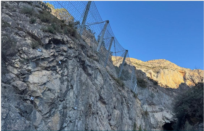
Vista de las barreras en la entrada al túnel
