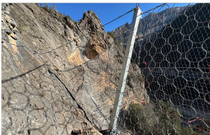
Cables laterales de la barrera RB3000
