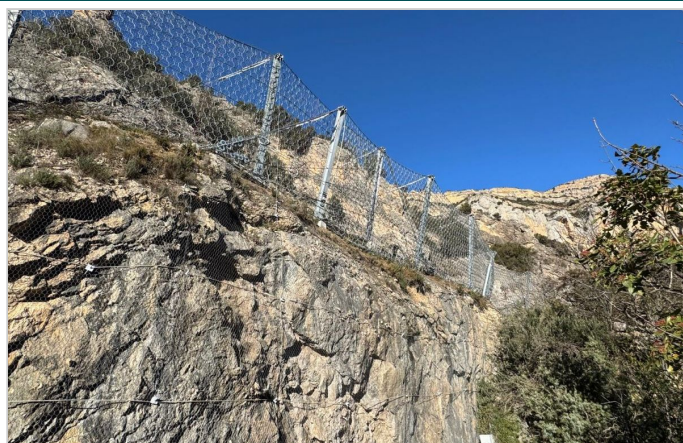
Instalación de barreras lado valle
