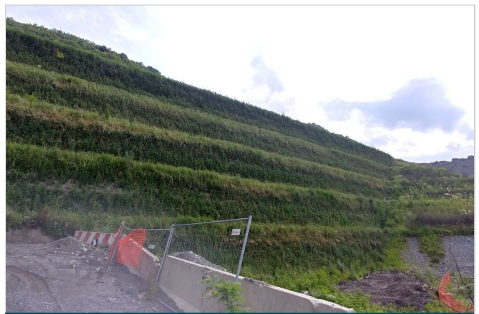
Vista laterale del rilevato in terra rinforzata con paramento verde e geogriglie
