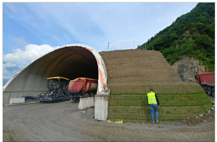
Vista frontale dell'imbocco ovest della galleria
