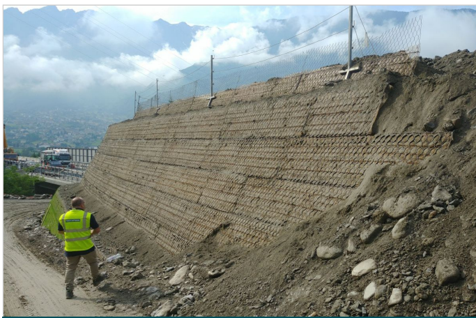
Vista laterale dell'imbocco ovest della galleria
